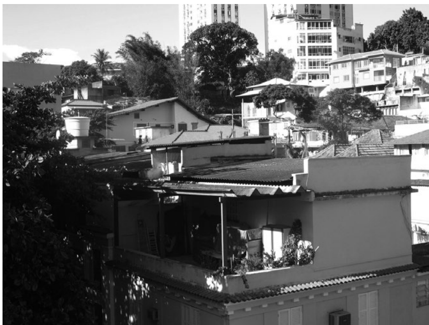
Fig. 13. Acréscimo no terraço de edifício da Praça Múcio Leitão.
