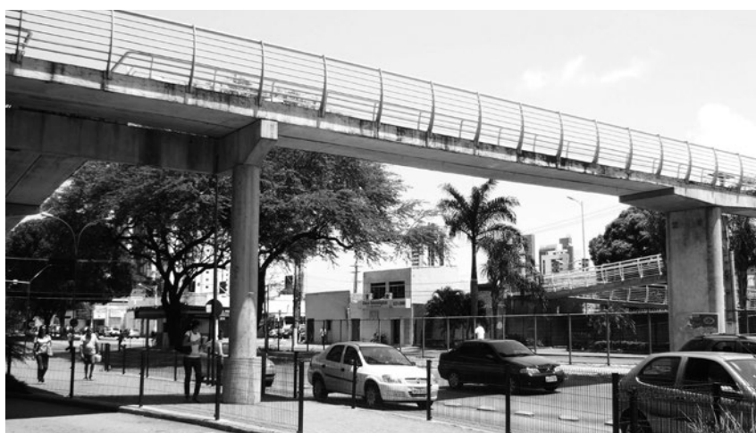
Fig. 3. Prioridade para os automóveis; passarelas e cercas para pedestres numa avenida em Natal.
