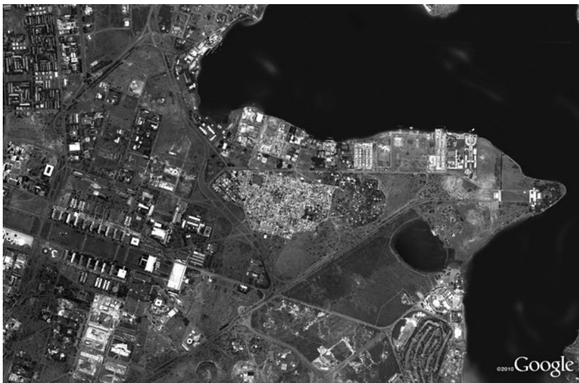
Fig. 2. Vila Planalto. Vista aérea, revelando a variedade de bairros, ruas, lotes e edifícios.
