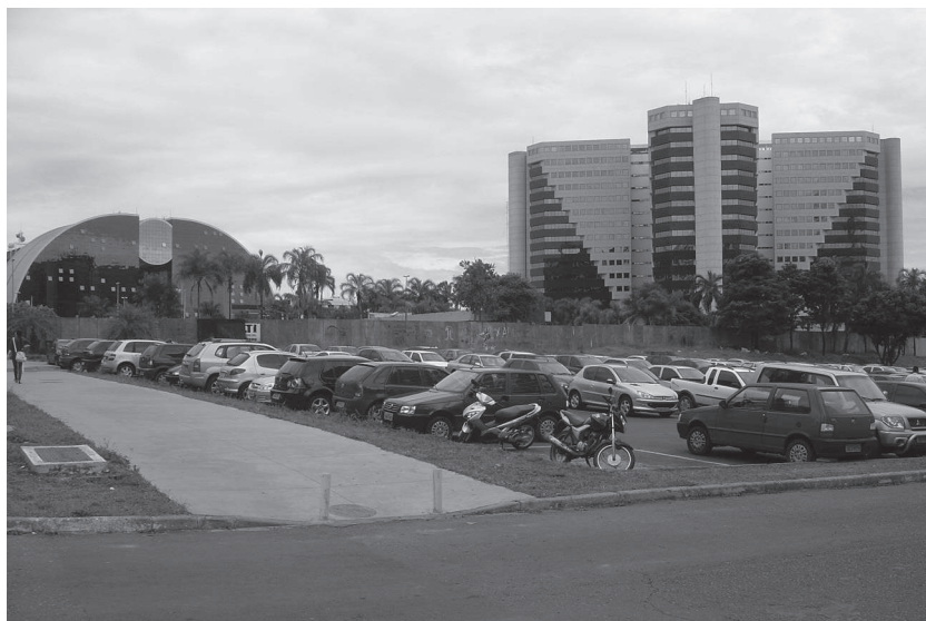
Figura 13.5. Setor Comercial Norte, Brasília. (Fonte: Autor.)
