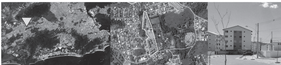
CHIS 42 – ZONA OESTE– Estrada João Melo, 485 – Campo Grande.
